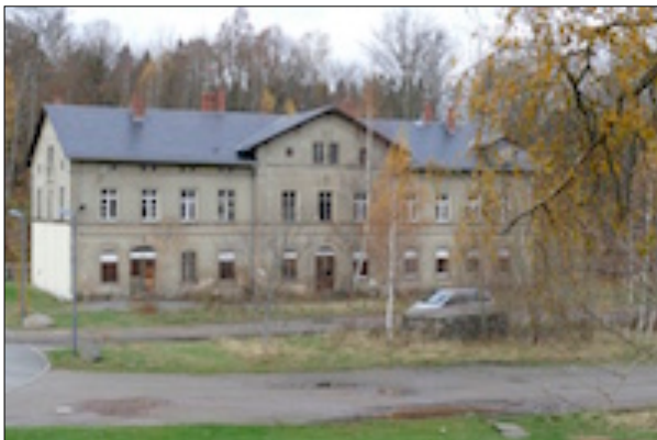
Abbildung 144: Ehemaliges Bahnhofsgebäude am Bahnhofs Gelände
