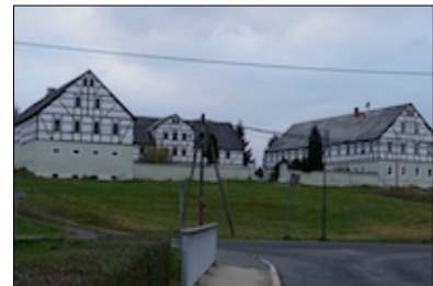
Abbildung 33: Gut Gahmig vor dem Umbau
