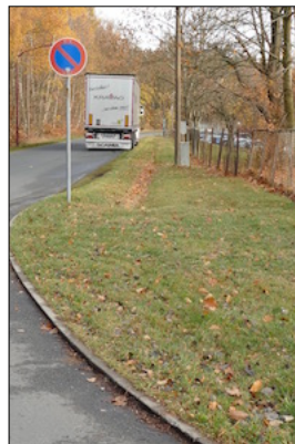
Abbildung 145: Fehlender Gehweg zwischen Gewerbepark Klingenberg und Bahnhof Klingenberg-Colmnitz
