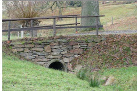
Abbildung 13: Ortstypische Brücke aus Naturstein
