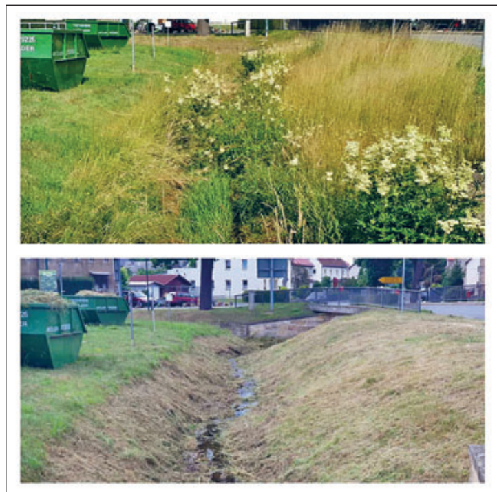
Gewässerpflege und Hochwasserschutz im Ortszentrum von Ruppendorf.
