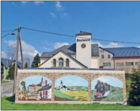
Erstplatzierter Eckhard Clausnitzer Wandbild Bäckerei Sauer in Pretzschendorf
